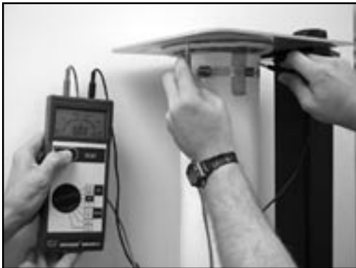
Colector de polvo de acceso inferior: prueba de resistencia entre la jaula y el espejo.
